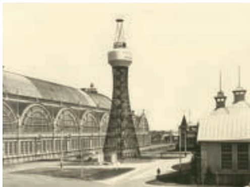
Гиперboloидная башня. Инженер В. Г. Шухов
